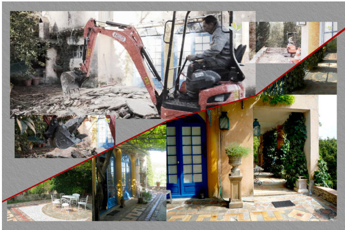
La terrasse de la Casa Nieves, avant et après les travaux.
