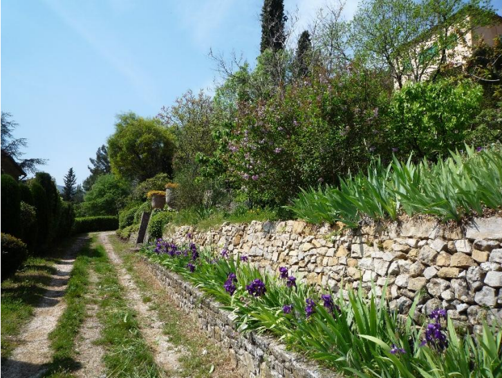
Restanque de l'allée précédant le grand escalier avant travaux
